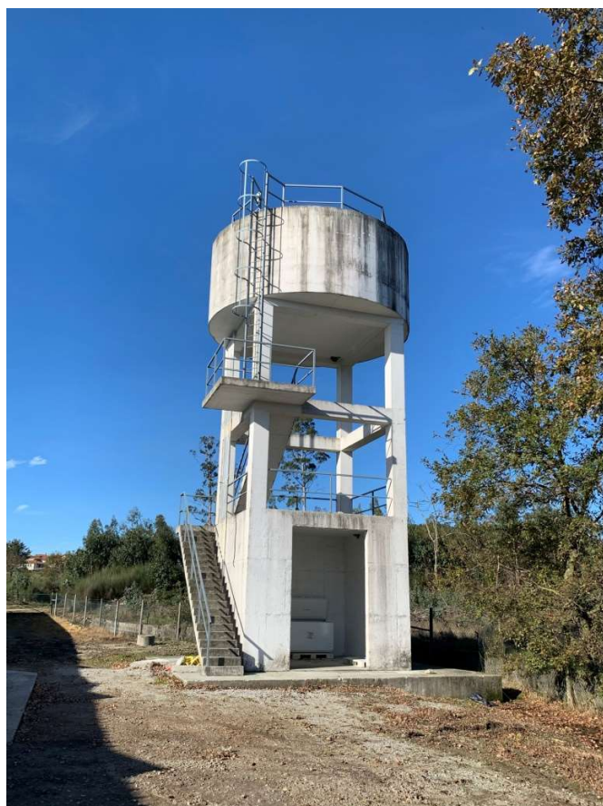
Figura 3.2.11. Reservatório de Água
