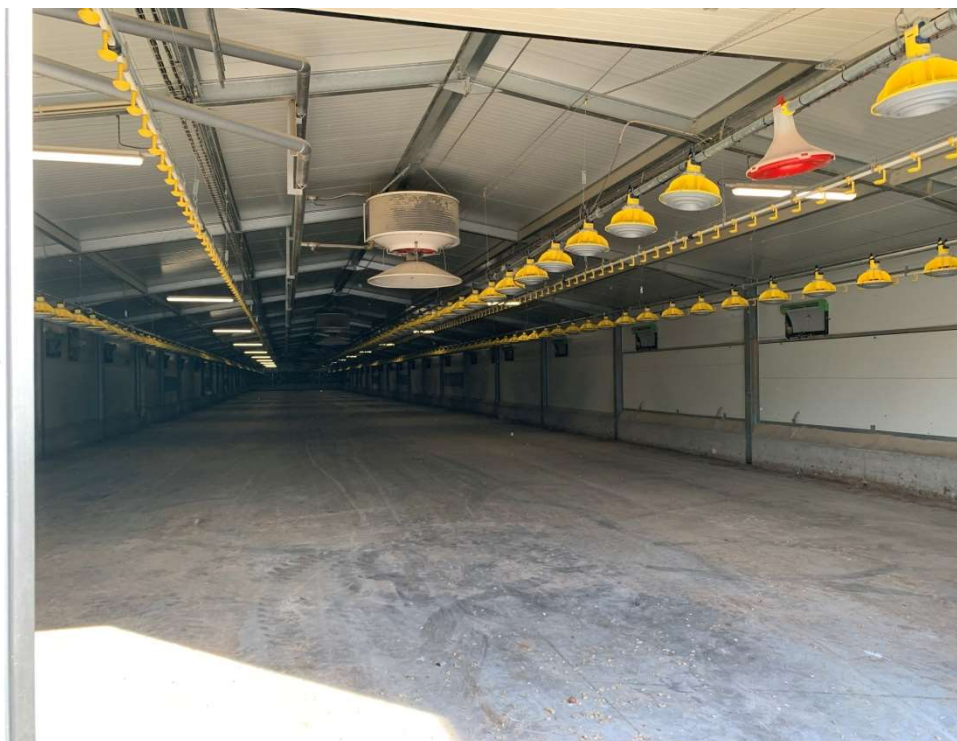
Figura 3.2.5. Interior do Pavilhão Avícola n.º 2 após a saída das aves
