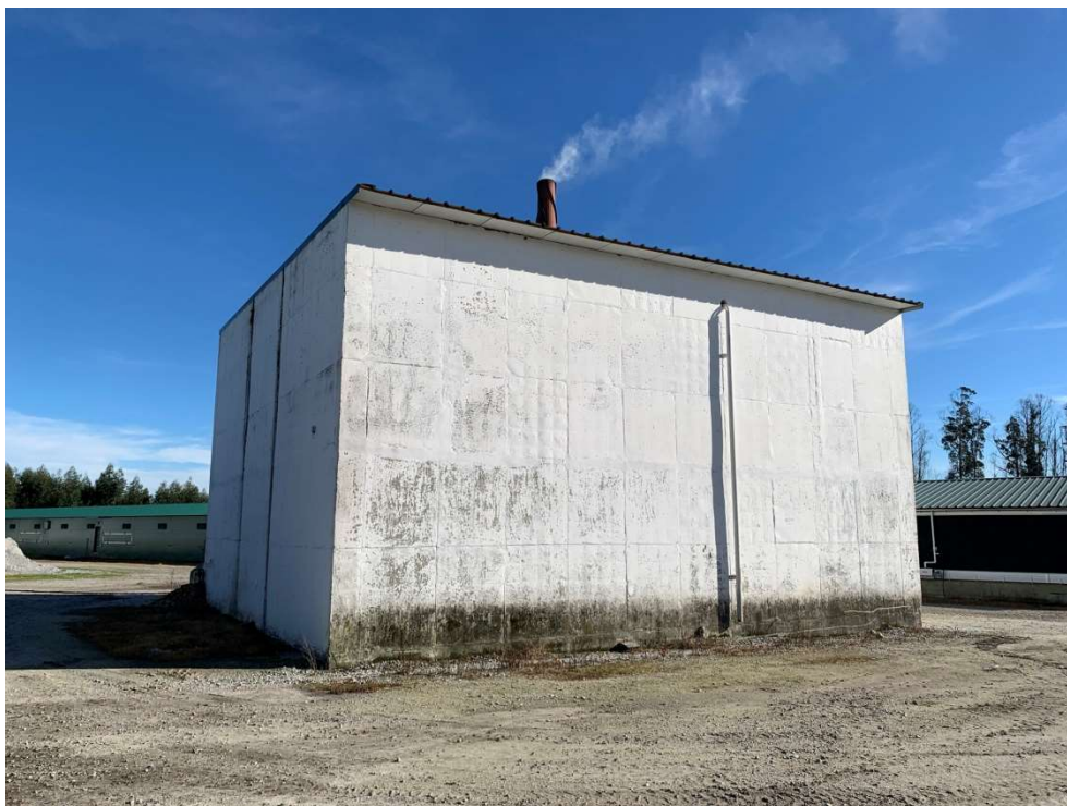
Figura 3.2.10. Edifício da Caldeira
