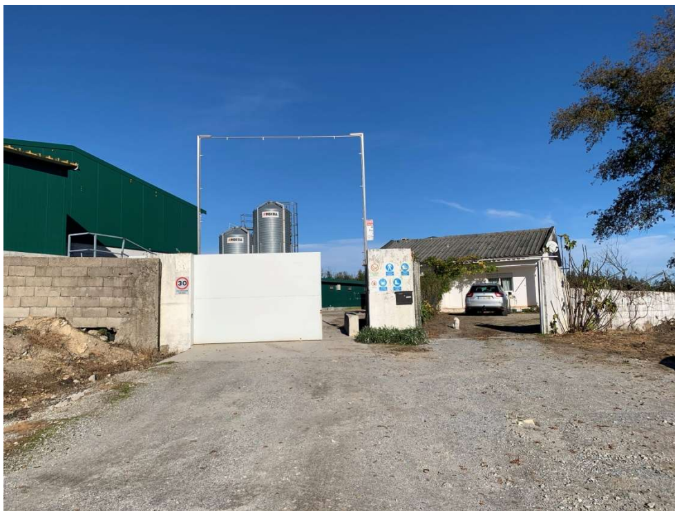
Figura 3.2.2. Entrada da Instalação Avícola e da Casa do Tratador
